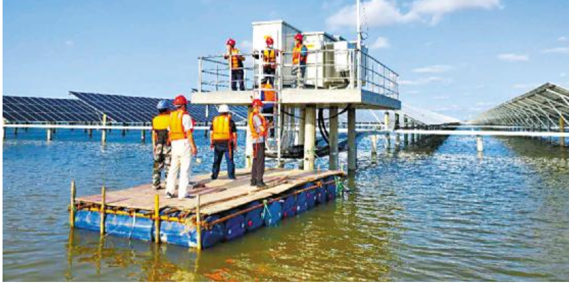
滨州沾化项目施工现场
