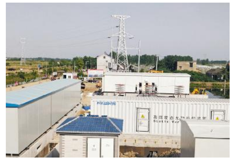
通威湖北公安项目升压站建设现场
