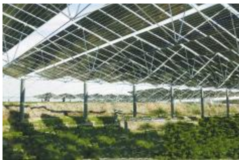
通威天津杨家泊二期项目柔性系统
