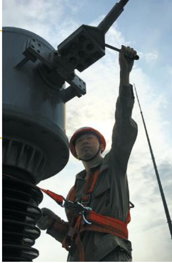
▲ 通威广西钦州电站投运期间开关站检查
