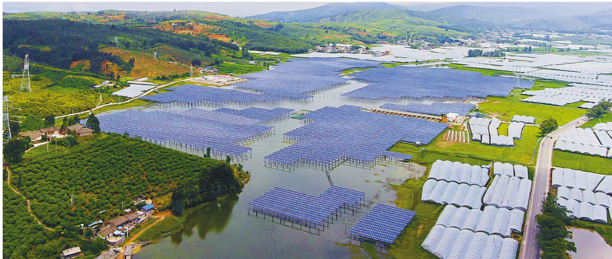
通威西昌“渔光一体”基地
