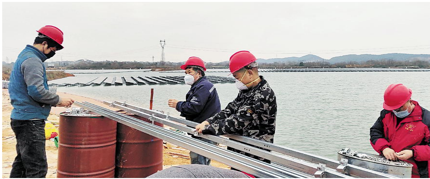
江西高安项目施工现场
