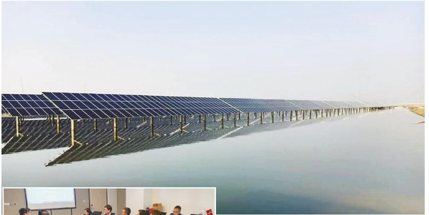
通威滨州沾化通汇300MW“渔光一体”光伏发电项目
