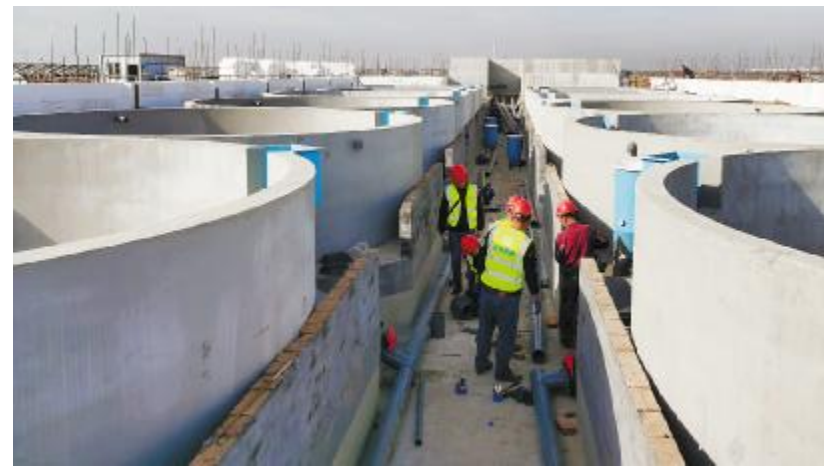
循环水养殖车间施工忙
