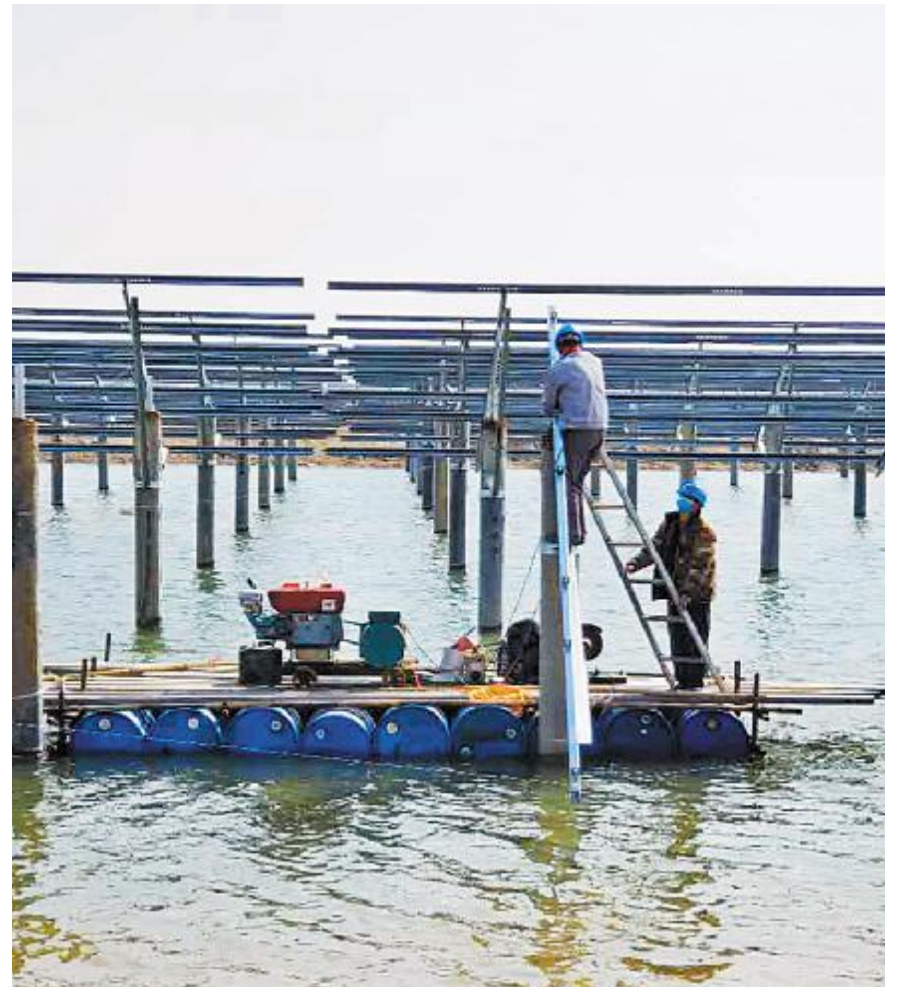
光伏区现场施工
