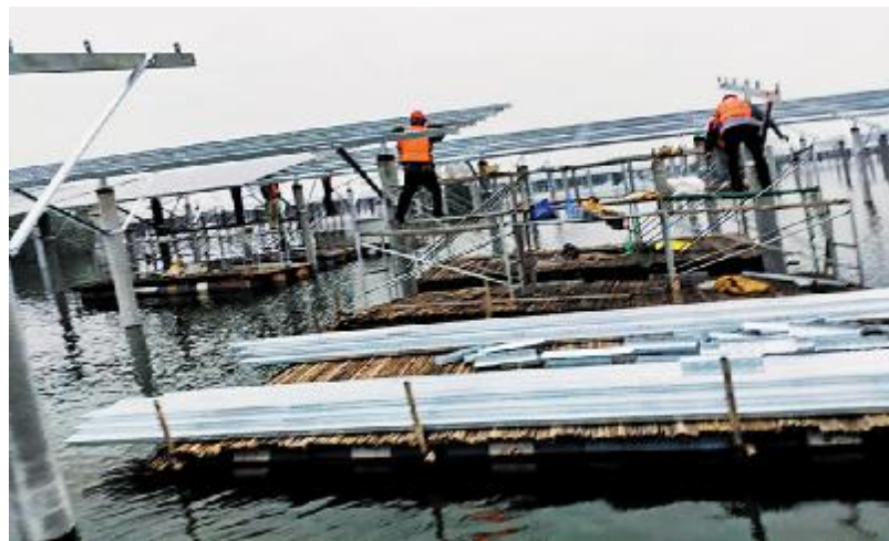
江西高安项目支架安装
