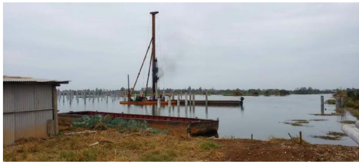
湖南常德项目利用北斗定位系统打桩
