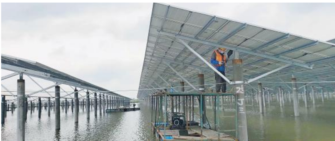
湖南常德项目安装光伏组件
