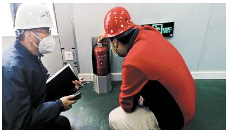
消防器材检查
