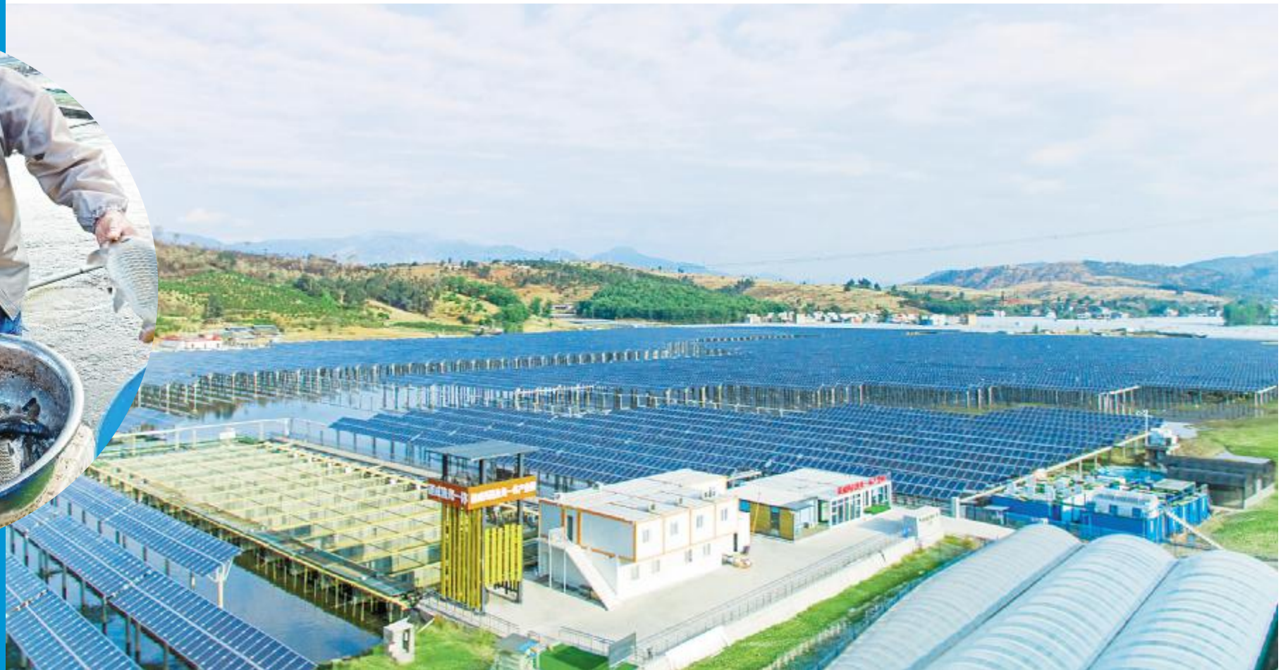
通威西昌“渔光一体”基地
