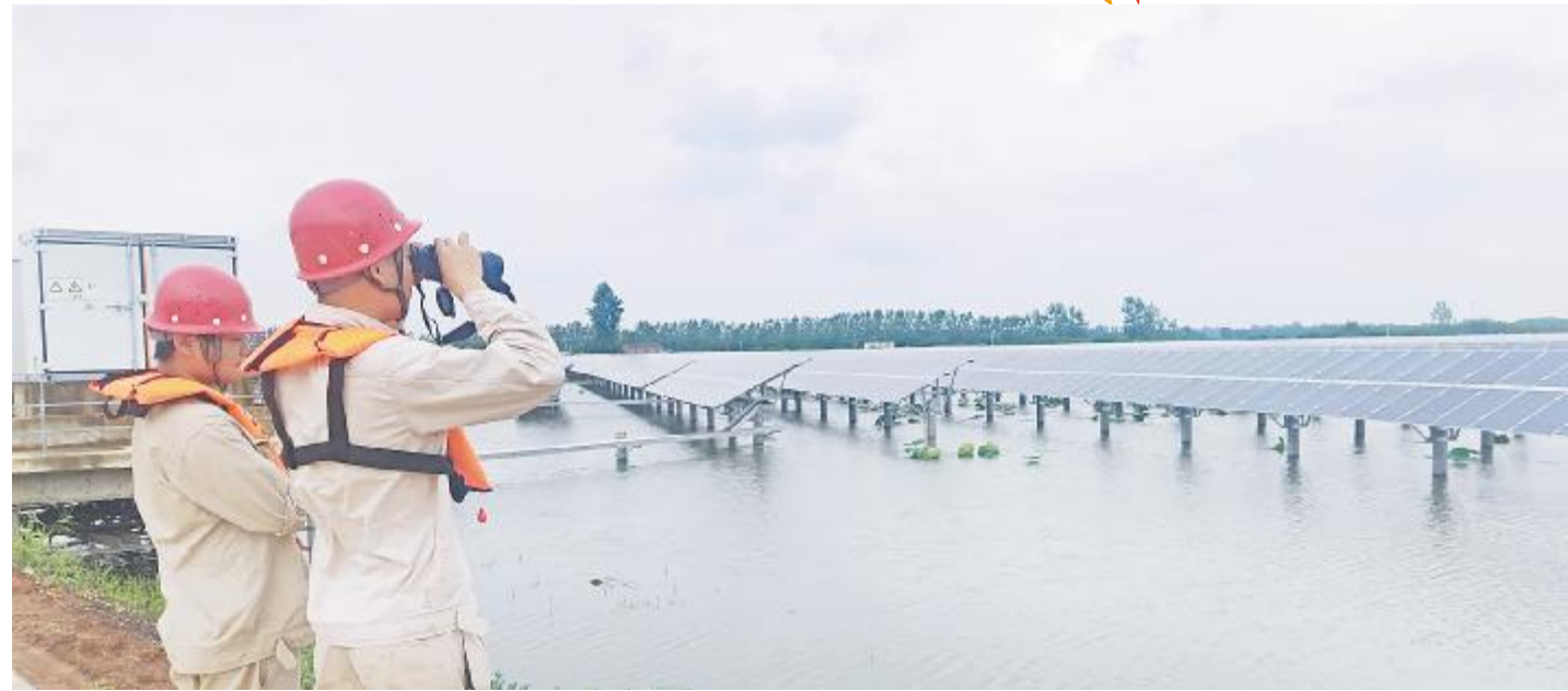
运维人员观察水位上涨和天气情况
