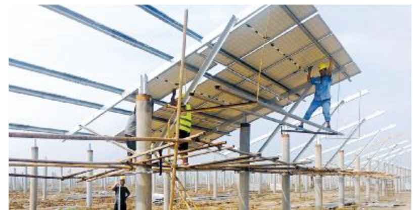
抢抓晴天间隙进行组件安装
