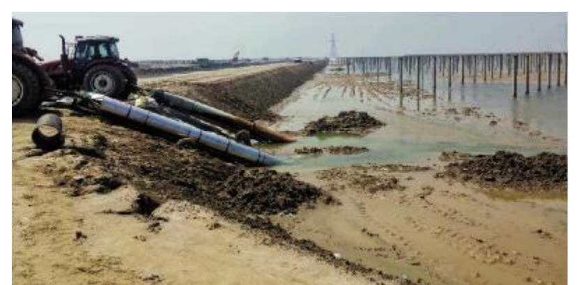
大扬程水泵抽水
