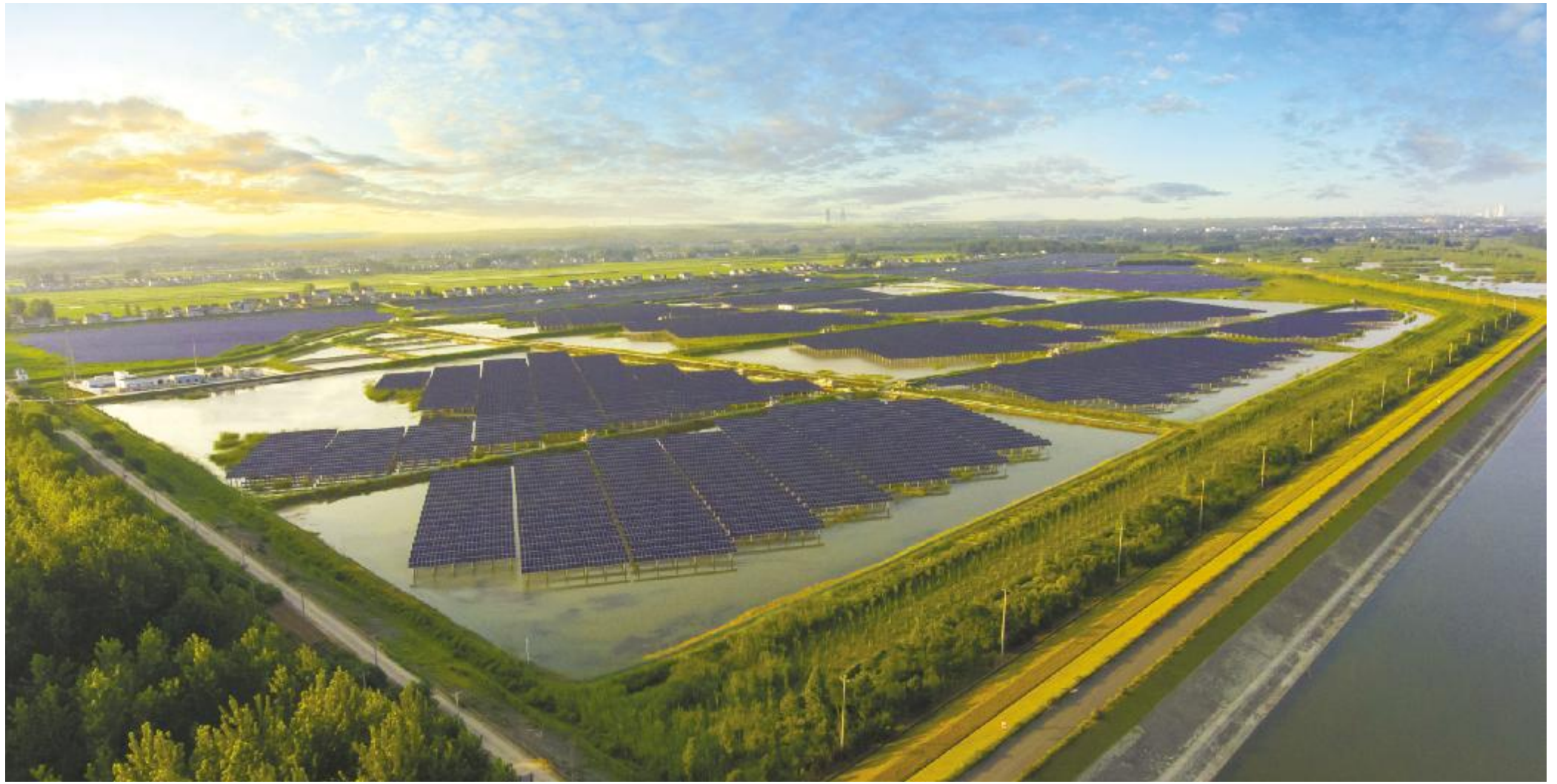
通威龙袍“渔光一体”基地
