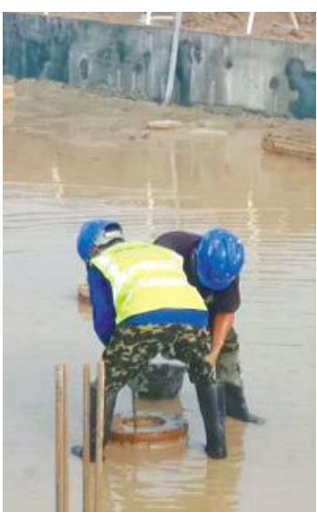
雨后管柱清理
